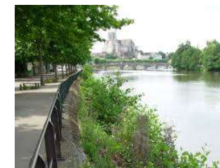
Photo : Quais de l'Yonne à Auxerre ; source : Mairie d'Auxerre
