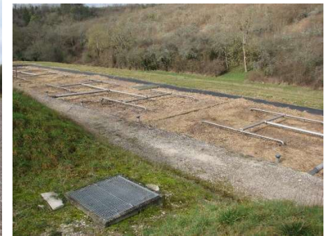
Lits plantés de roseaux – Station d'épuration d'Irancy (installation récente) ; source : Etude de préfiguration assainissement CA Auxerrois 2018
