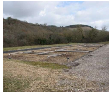
Lits plantés de roseaux – Station d'épuration d'Irancy (installation récente) ; source : Etude de préfiguration assainissement CA Auxerrois 2018
